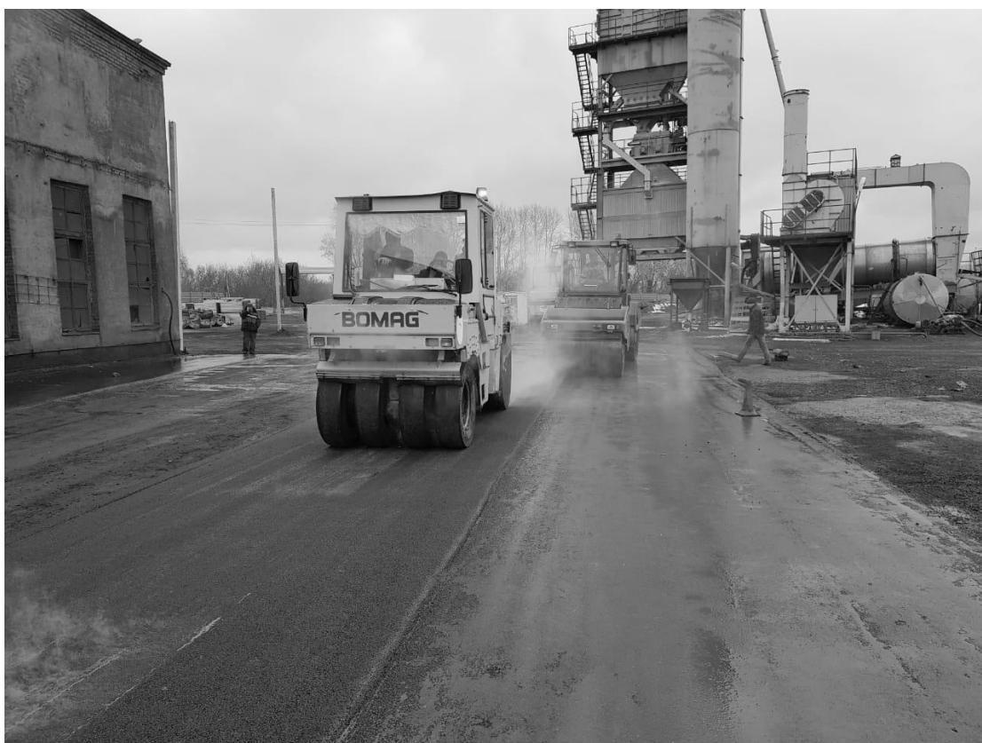
Рисунок 6.6. Устройство покрытия из модифицированной нанодобавкой TUBALL™ шлакоасфальтобетонной смеси на территории металлургического комбината в г. Новокузнецке
