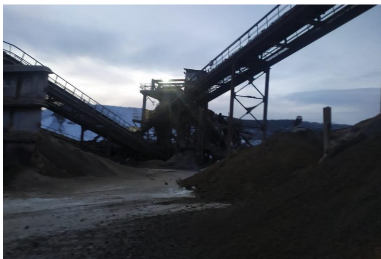
Рисунок 1.2. Хранение и сортировка сталеплавильных шлаков в отвалах (Кемеровская область)
